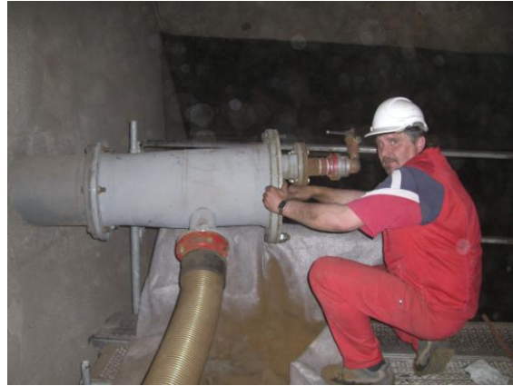
Molchschleuse DN 300 mit Druck- und Vakuumanschluss
