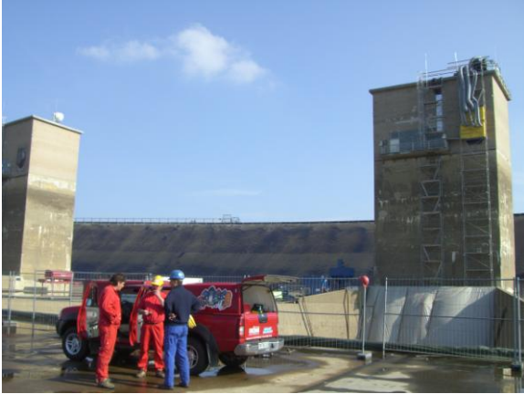
Baublaufberatung im Speicherbecken am Einlaufftor
